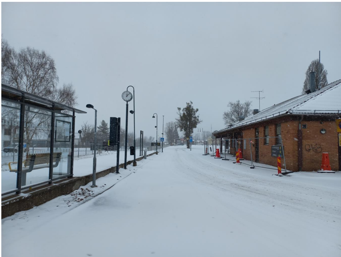
Befintlig stationsbyggnad sett från bredvid perrongen, busstorg i bakgrunden.
